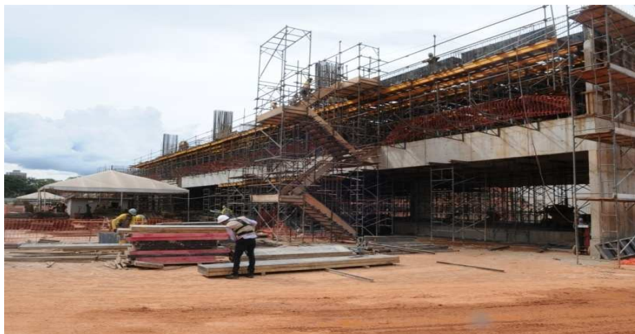
Nova Sede do Tribunal na etapa de elevação do Bloco D
