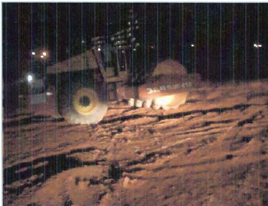
Foto 22 – Terraplenagem período noturno
