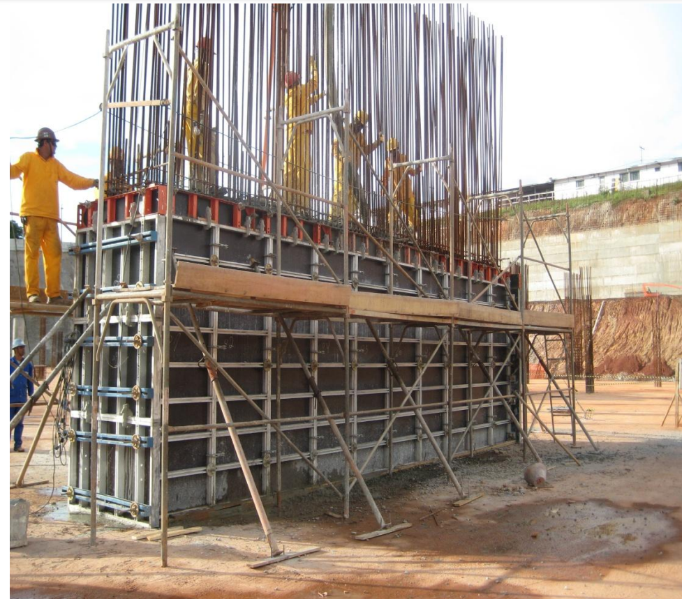
Foto 3- Forma plana Pilares 3º subsolo, trecho VI (compreendidos entre os eixos Q-U e 8-11), ref. Item 03.02.110.1.01 no Memorial descritivo
