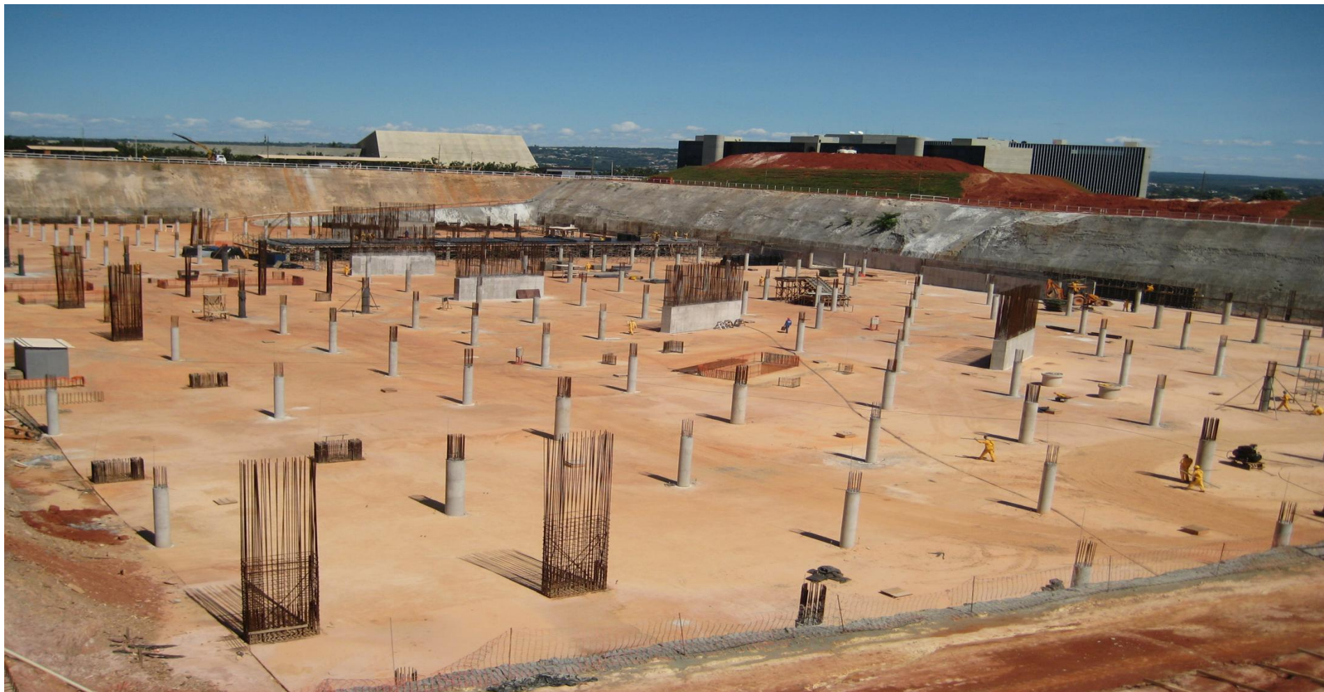
Foto 1 – Vista Geral da Obra
