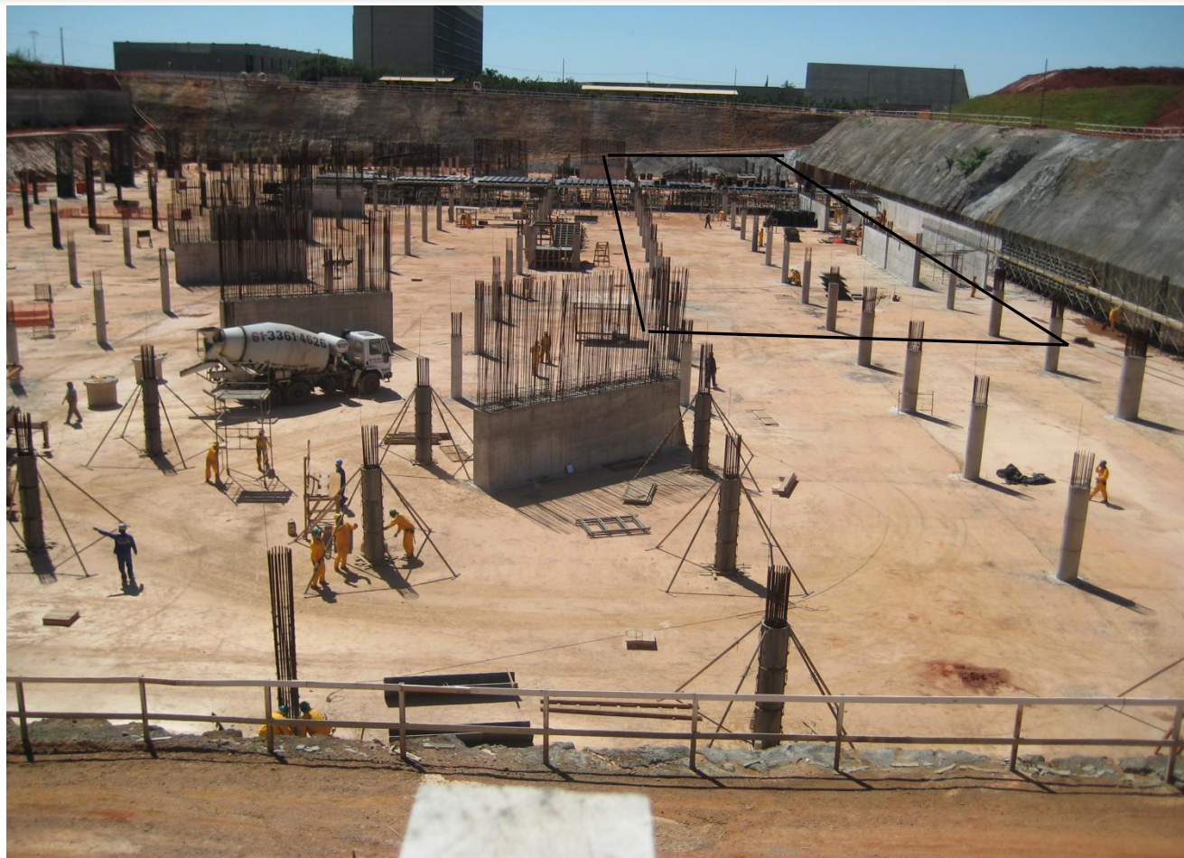
Foto 12 – Concreto Pilares 3º subsolo, trecho V entre os eixos 11 e 13, ref. Item 03.02.700 no Memorial descritivo
