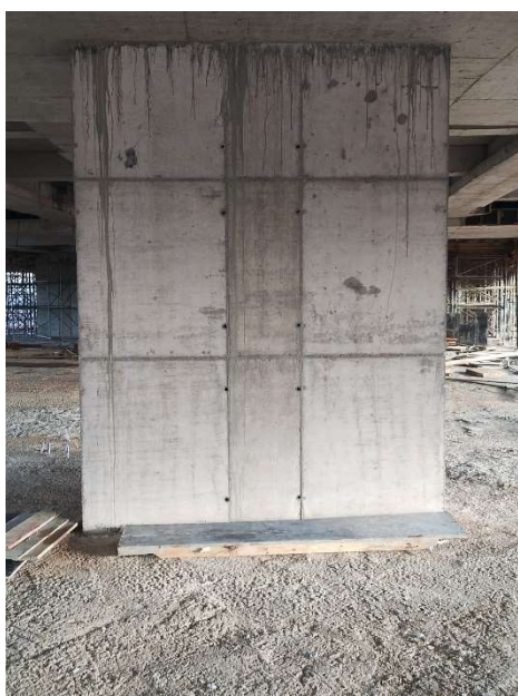
Foto 01 – Vigas de concreto armado.
