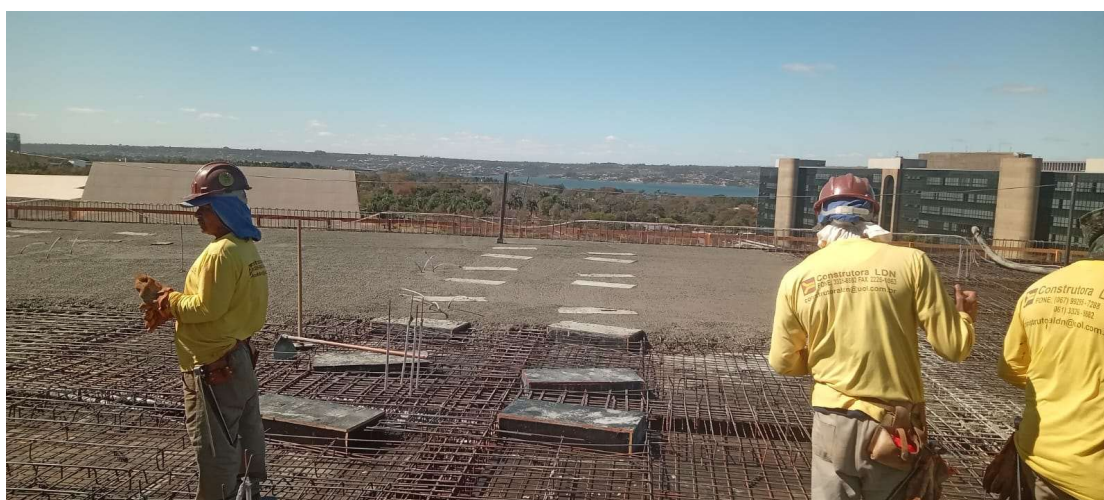
Foto 04 – Vigas de concreto armado
