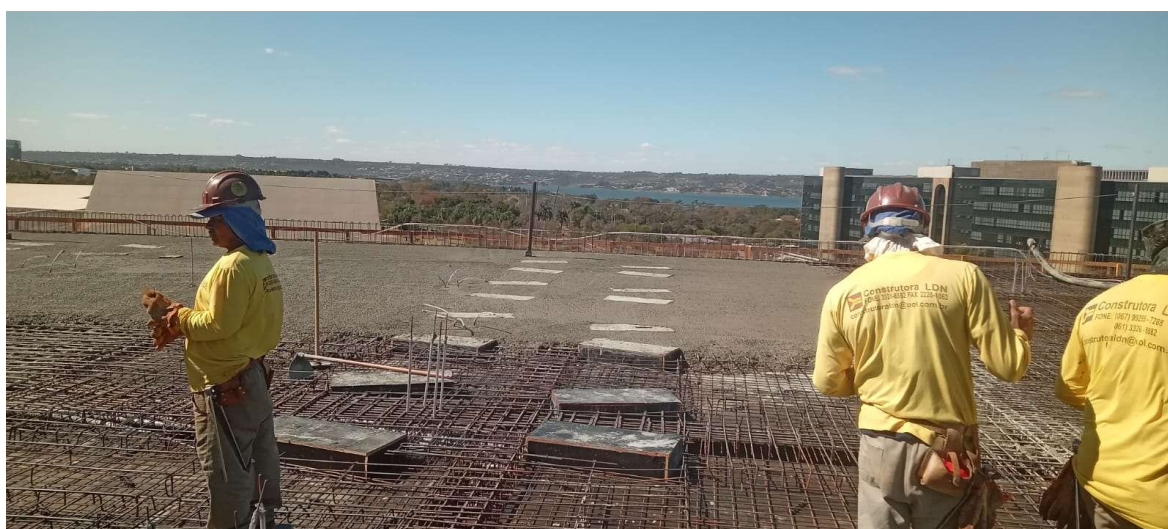
Foto 05 – Vigas de concreto armado
