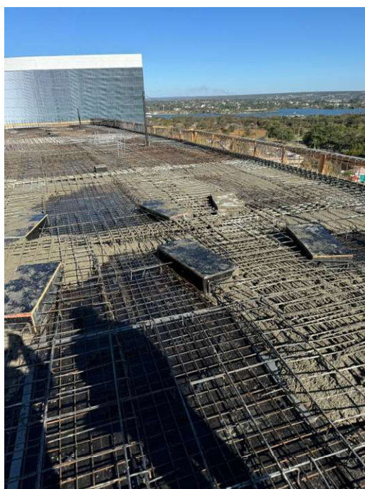
Foto 02 – Vigas de concreto armado.
