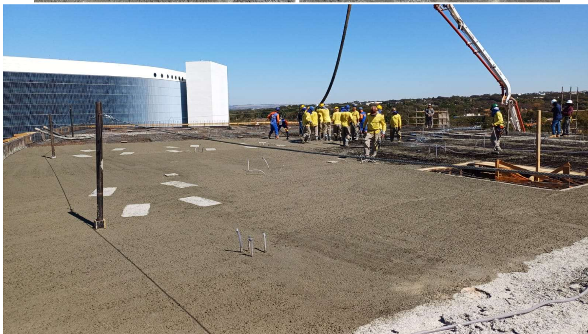
Foto 07 – Laje de concreto
