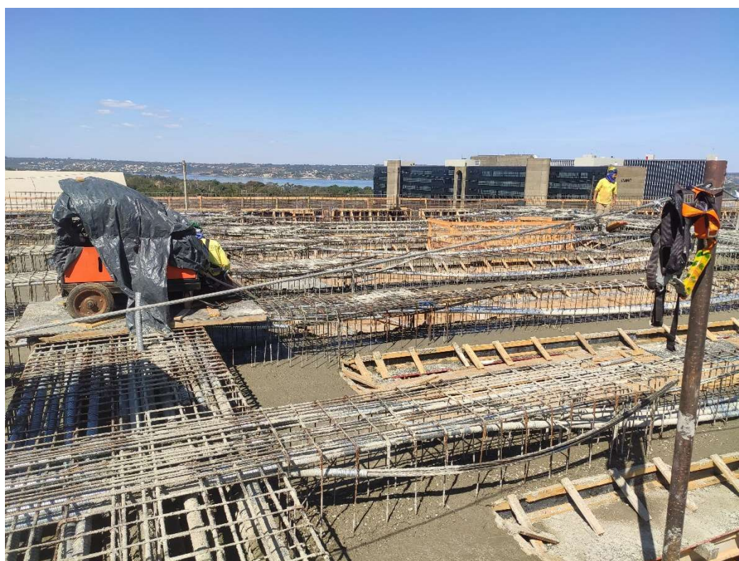
Foto 03 – Vigas de concreto armado
