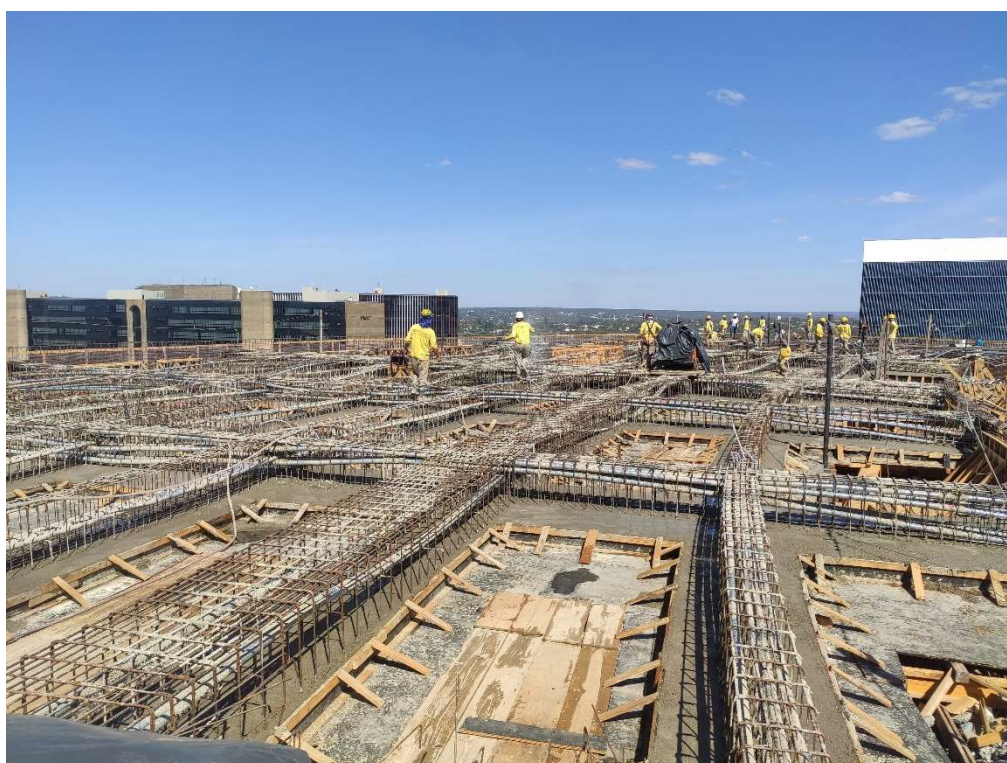
.Foto 02 – Vigas de concreto armado
