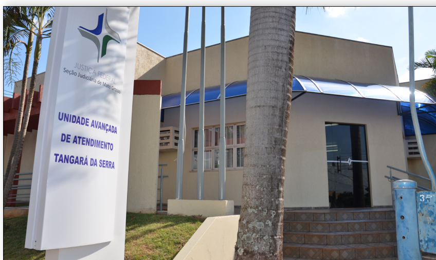
Instalação da Unidade Avançada de Atendimento de Tangará da Serra, em 18/12/2015.
