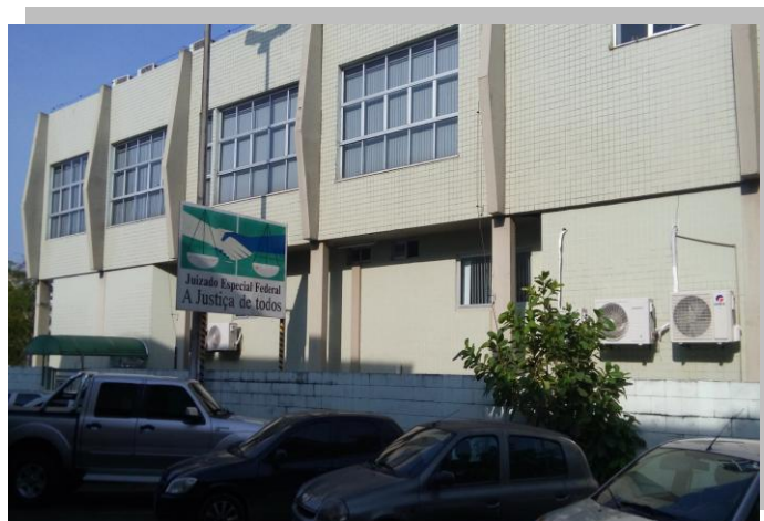
Figura 7 — Edifício Rio Solimões
